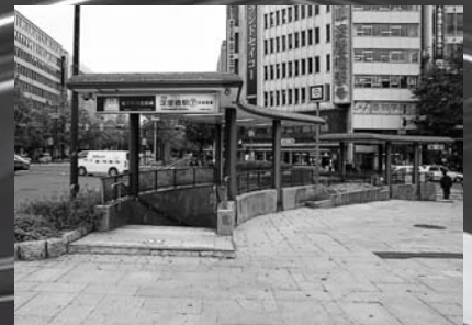
淀屋橋駅の地上出入り口。上屋は変わっているが、カーブを描く階段は、ホームのヴォールト天井に結びつく、オリジナルの形状ではなからうか
