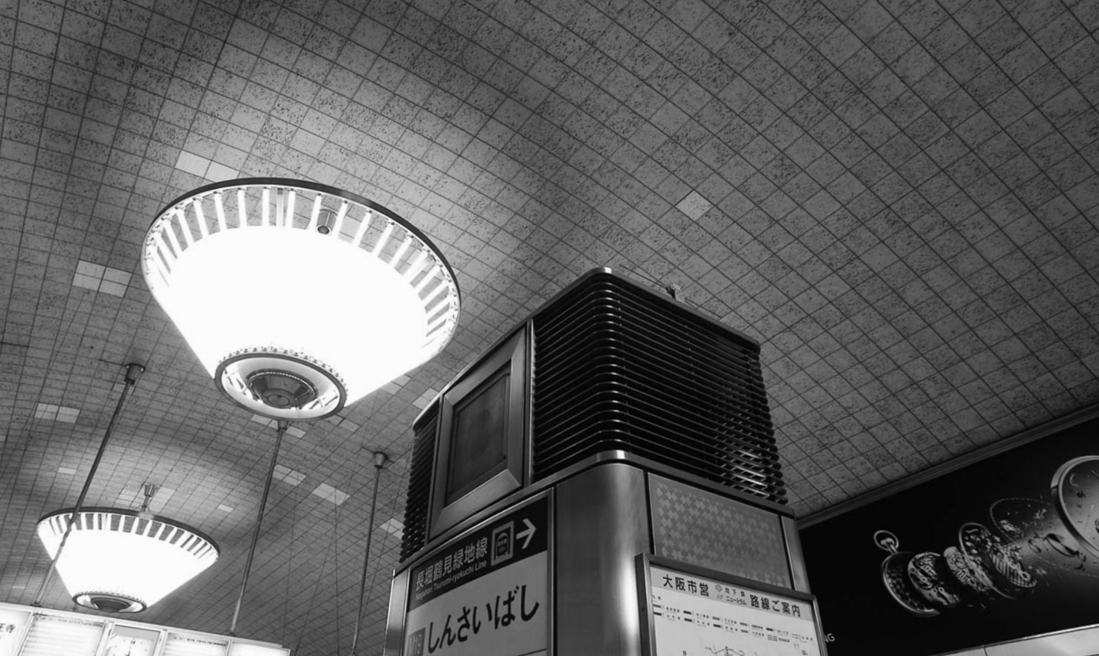
心斎橋駅ホームの照明は、数十本の蛍光灯を菊の花びらのように並べてある。繁華街の玄関口にふさわしい艶やかな「シャンデリア」である
