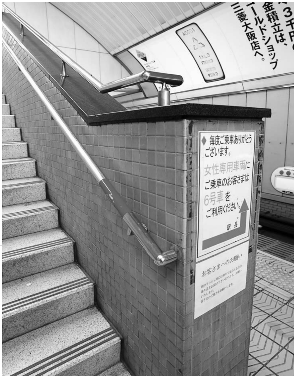
階段手摺りの壁をずっと守り続けているタイル。当初は、天井や壁などにタイルは多用されていたと思われる
