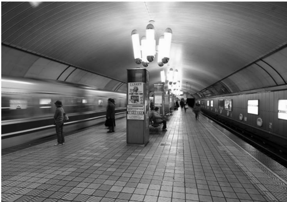
路線も含めて昭和5 (1930) 年着工の地下トンネルは、開削工法で造られた。 軟弱地盤の土留めに、ドイツの鋼板や機械を導入するなど、大変な難工事であったという
