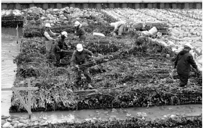
岐阜市の長良川で施工された粗朶沈床工の現場 (2010年2月撮影)
