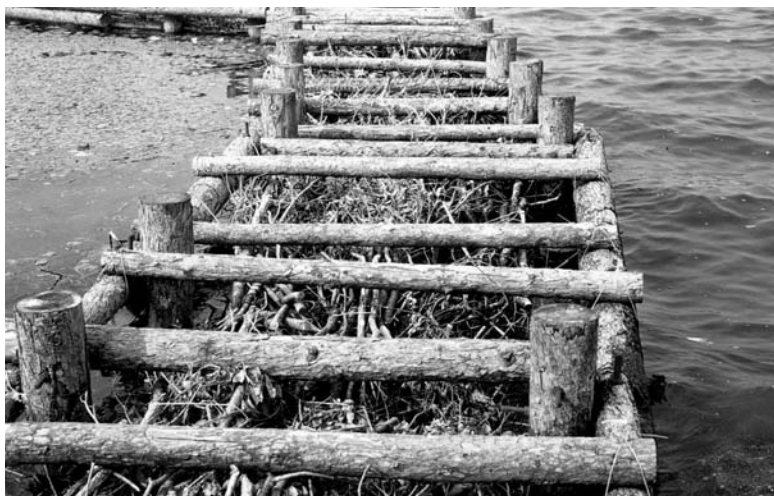
茨城・霞ヶ浦でアサザの再生のために活用された粗朶消波堤 (NPO法人アサザ基金提供)
