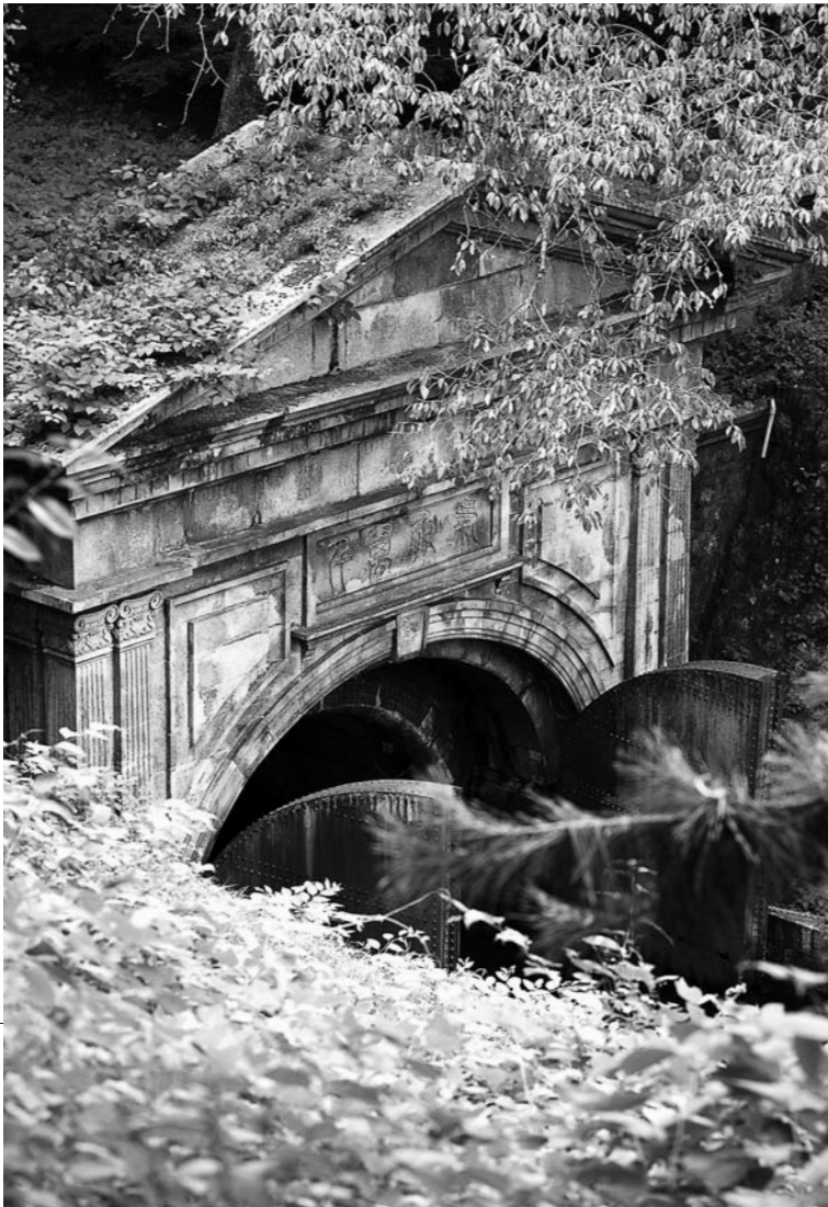
石張り仕上げがなされた第1トンネル入口。三角破風や付け柱など古代ギリシアの様式を見事に再現している中、石壁には欧文で田辺の名が
