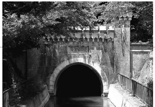
第3トンネルは、再び正円のアーチに戻る。田辺は、トンネルの出入口を、門・玄関として考えていたようだ
