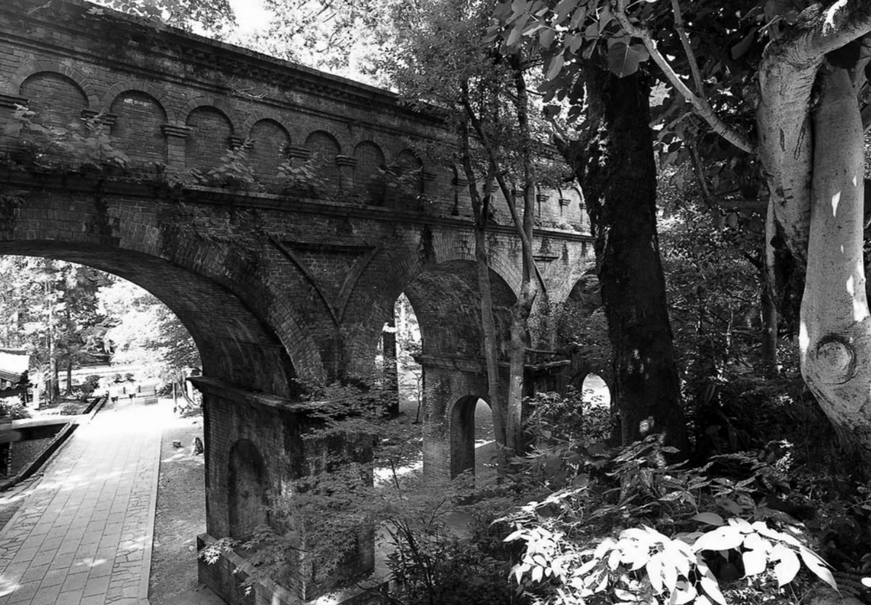
大小2つのアーチが直行する複雑な構造の水路閣(長さ93m、高さ10m)。 壁面にも入念に装飾が施され、洋風建築としても秀逸な出来
