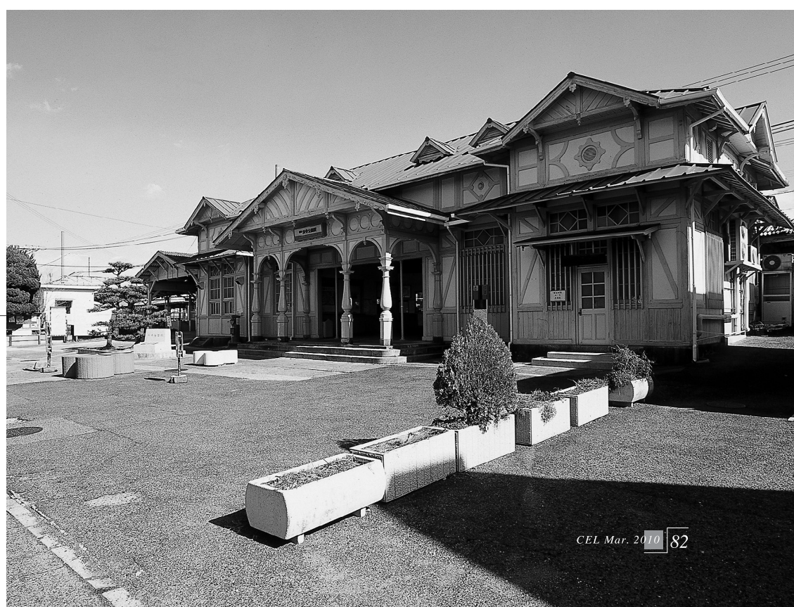
浜寺公園駅舎全景。中央の玄関を挟んで、手前に一等待合室、奥は駅務室になっている
