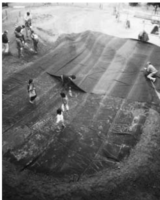
被災した児童のために、神戸市が推進する「学校ビオトープ計画」において、遮水ゴムシートの無償提供と社員ボランティアによる施工協力を実践。「ビオトープ池のネットワーク」を広めている
