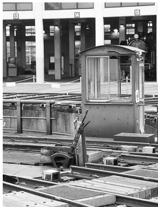
鉄路を固定するレバーは手動だ。転車台は今では電動だが、かつては人力だったという
