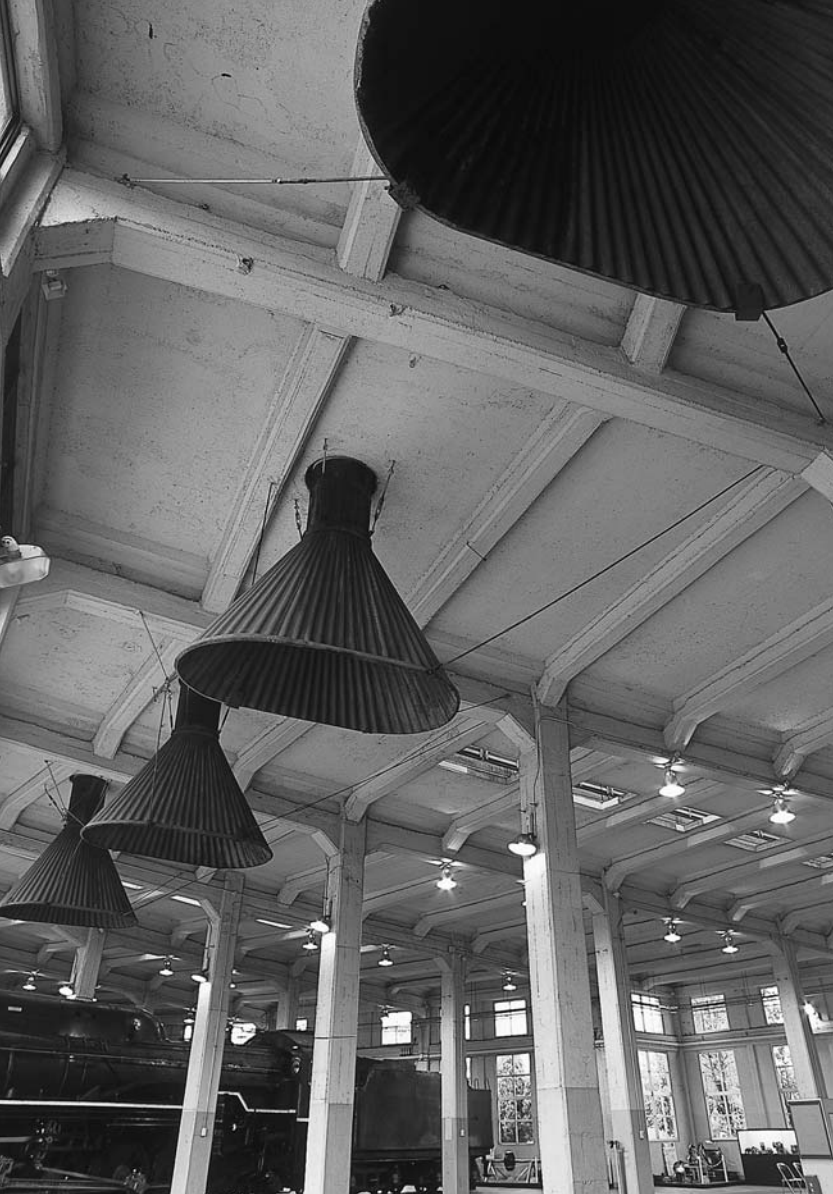
車庫天井から下がる排煙装置の圧倒的存在感。強制換気が否かは不明
