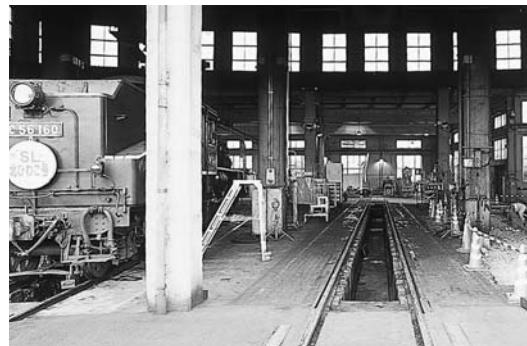
深さ約70cmの溝は、車体下面の点検用。もぐっての作業は大変だ
