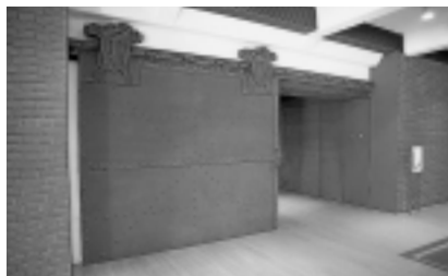
建物内部には、かつて倉庫だった時に使用されていた防火扉などを、取壊してそのまま残して使用している。凝った意匠など、現代建築ではほとんど見ることができないものも多く、まさに『歴史』が感じられる
