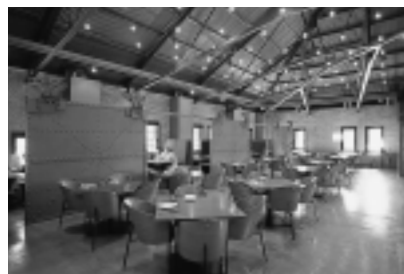
2号館の最上階(3階)にある「BEER NEXT」(ダイニングレストラン)の屋根は、倉庫時代のままに鉄骨やトタン屋根が剥き出しになっているが、それがまたレトロな雰囲気を生み出している
