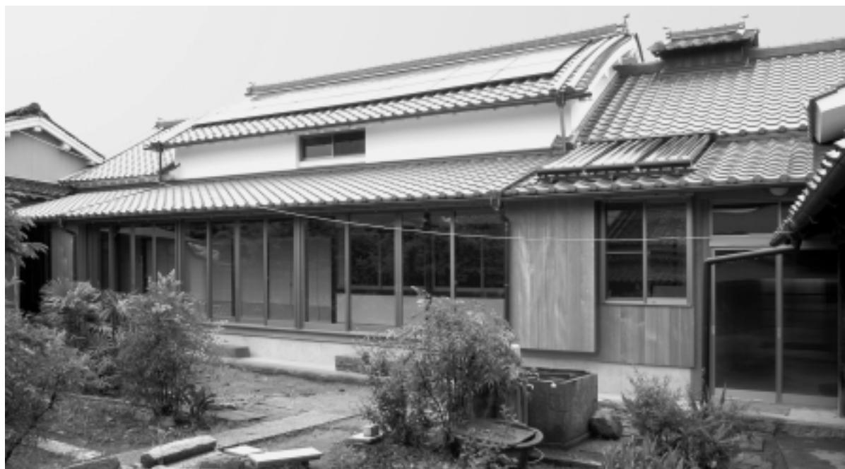
再生なったH邸の外観を南側の庭から見る。右ページの改修前と比較すると、どこがどのように改装されたかがよく分かる。なお屋上に設置されているのは、太陽光発電パネルと太陽熱温水ヒーターで、エネルギーの有効活用を図っていて、まさに新旧の技が入り混じった『ハイブリッド再生』がなされている
