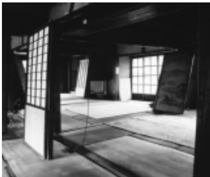
再生前のH邸。建物は設備的な制約から南側に風呂場などが設けられ、太陽の光をさえぎっていた。また内部も、長年の使用により建具などの損傷も進み、とてもそのままでは住み続けることができないような状態だった
