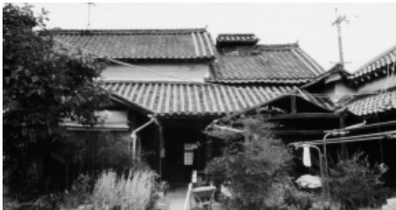
再生前のH邸。建物は設備的な制約から南側に風呂場などが設けられ、太陽の光をさえぎっていた。また内部も、長年の使用により建具などの損傷も進み、とてもそのままでは住み続けることができないような状態だった
