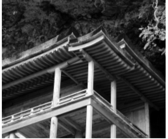
【写真4】投入堂の底細部
