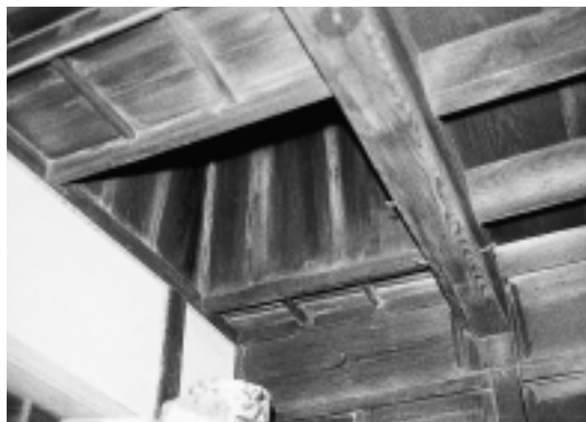
引窓の見上げ。ガス設備の普及により引窓は姿を消し、台所の上に2階を重ねることもできるようになった
