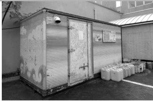
大学内の食堂裏に設けられた製油プラント。JRのコンテナを再利用し、製油の機械も廃棄されるものを探して手に入れたという、環境に配慮したハンドメイドのプラントだ
