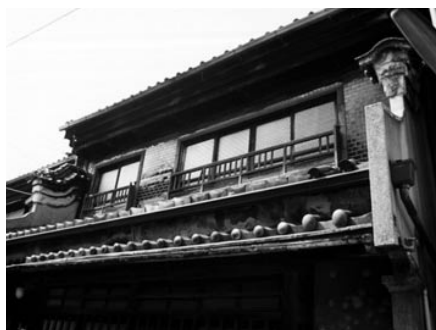
卯建のあがっている古い町家も少なくない
