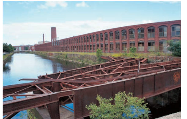
上/メリマック川に築かれたグレート・ストーン・ダム。 下/メリマック川沿いに残されている毛織物工場の建物。
