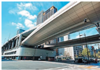
「船場センタービル」は、屋上に阪神高速道路と中央大通の高架道路が通る、知恵を絞った構造が特徴。写真提供/ピクスタ
