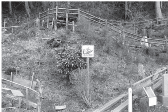
写真2 / 旅館の裏山で整備が進められている車椅子でも避難できる路。
