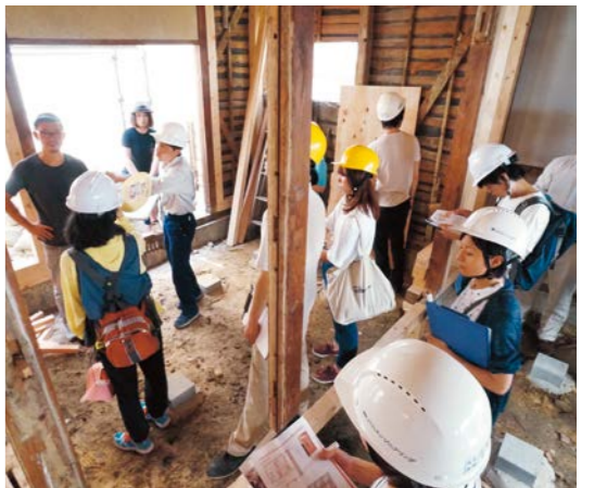
「耐震改修見学会」では、施工担当が耐震改修方法を説明。また「耐震補強計画の説明会」では、耐震設計者と工務店の話のほか、隣棟住人による大正地区と長屋暮らしの良さについても聞くことができた。
