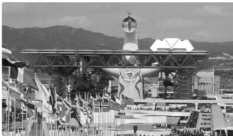
70年万博当時、太陽の塔はお祭り広場の大屋根から塔の上半分が突き出すように建っていた。写真提供/Picture Alliance/アフロ
