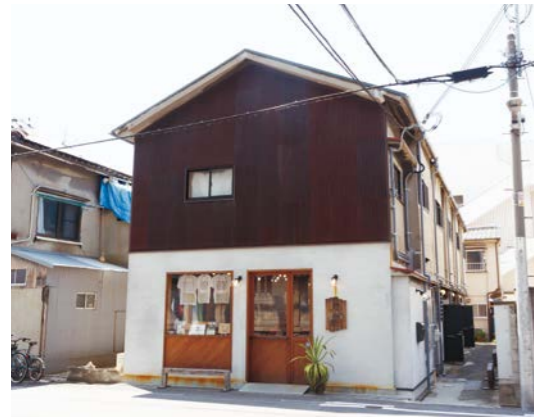
2棟ある長屋のうち右側(北棟)をリノベーションし誕生したシェアアトリエ「ヨリドコ 大正メイキン」。2階が住居、1階が店舗付きシェアアトリエになっている。「古い建物はカッコいいものだ」と知らせたい思いから、屋根に使われていたトタンを2階の壁に使ったり、古材をはりめぐらせていたり。
